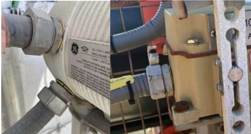
Figura 3-42 — Transmisor de Flujo AQCS e Interruptor de Límite de Manejo de Carbón con Juntas Seltas
