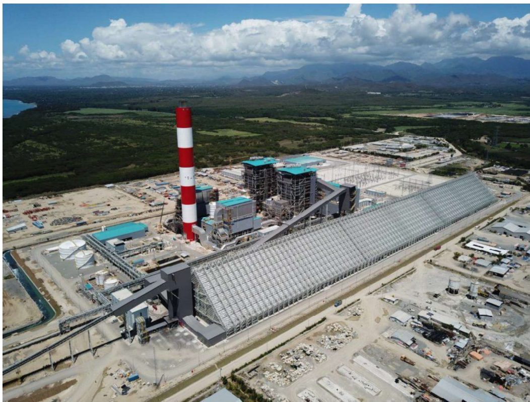
Figura 1-1 — Vista de la Central Punta Catalina
