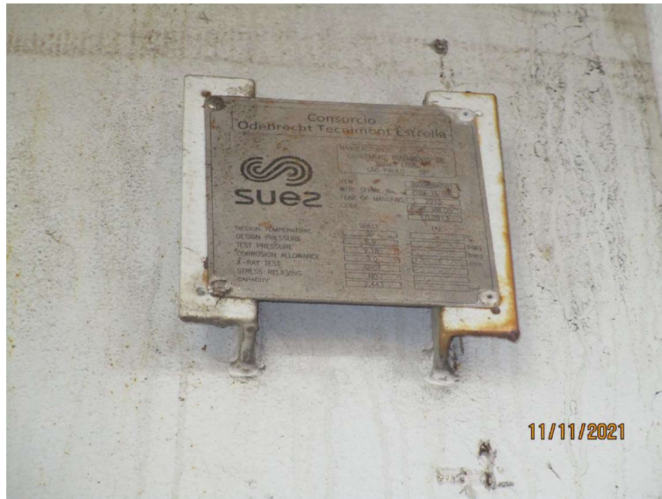
Figura 3-41 — Placa de identificación de los Recipientes de Filtros
