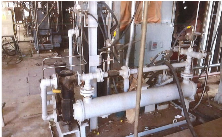
Figura 3-6 — Sistema de aceite pulverizador – Basura de construcción
