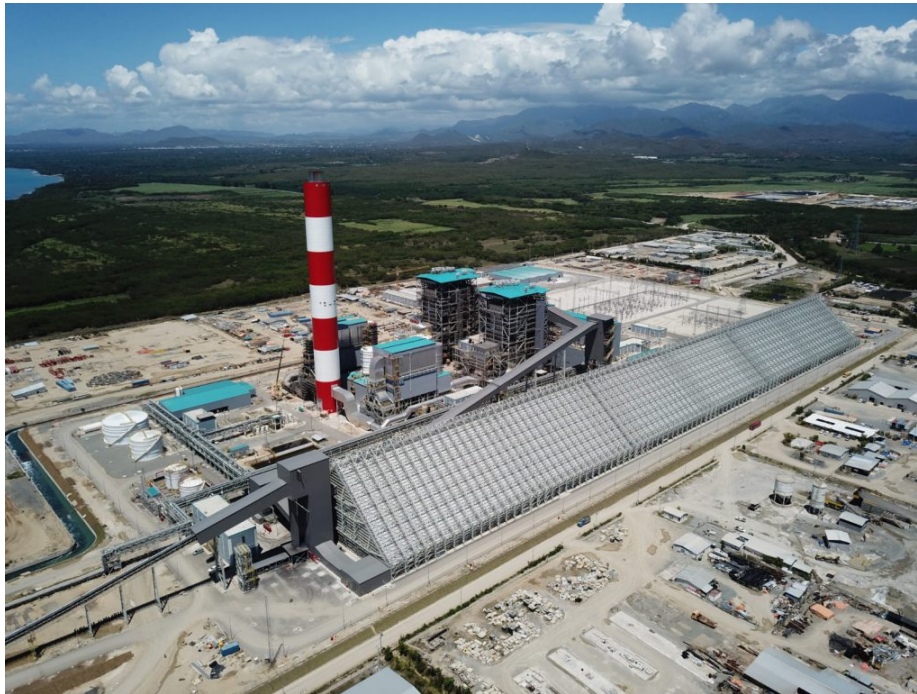
Figura 1-1 — Vista aérea de la Central Punta Catalina
